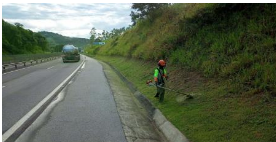
Figura 4.15 Via Lagos - Roçada Manual Talude - km 19+900 Norte
