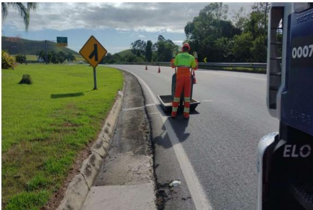
Figura 4.12 Via Lagos - Recup Sarjeta - km 23+000 Norte
