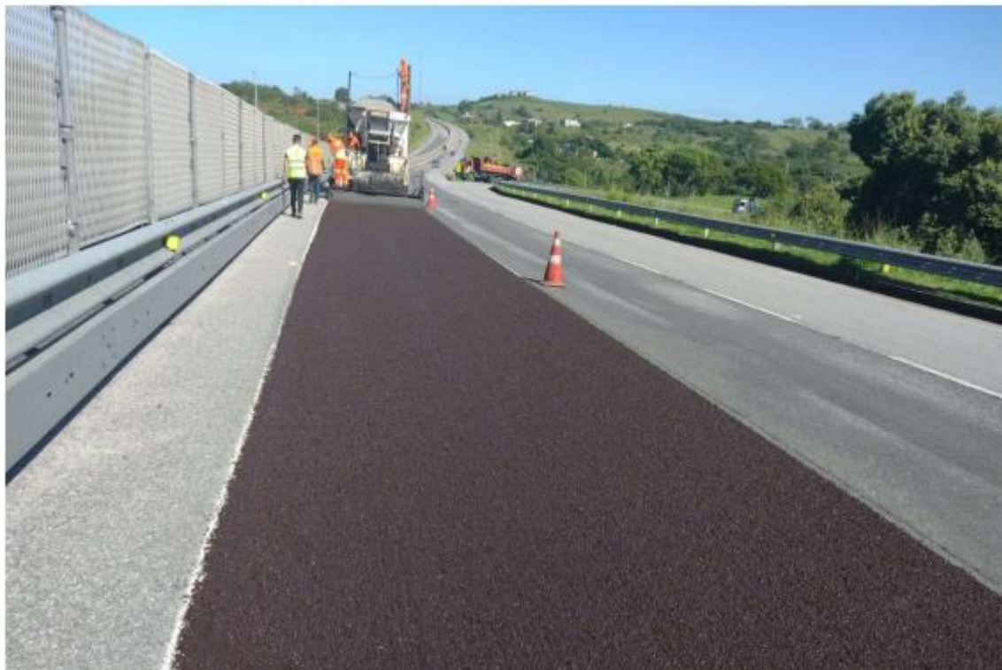
Figura 4.4 Via Lagos - Pista - Microrevestimento- KM 47 Sul
