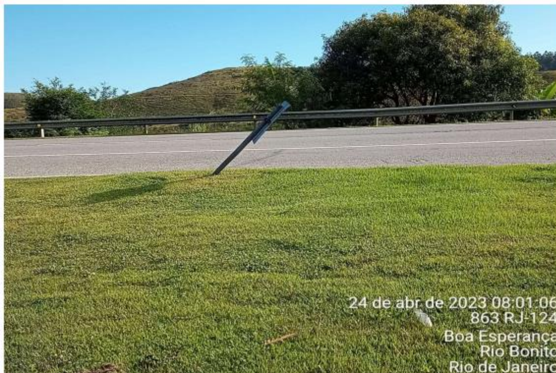
Figura 4.7 Via Lagos - Sinal Vertical - Km 17+000 Norte
