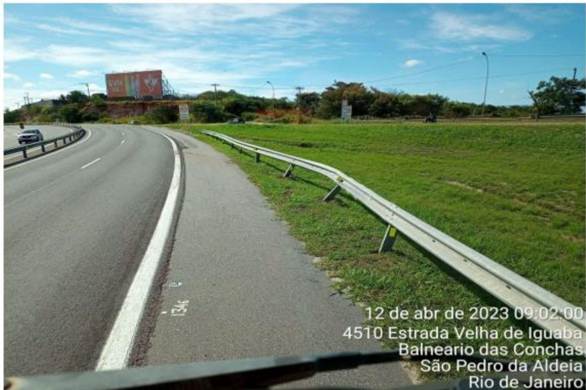
Figura 4.10 Via Lagos - Defesa - km 56+920 Norte
