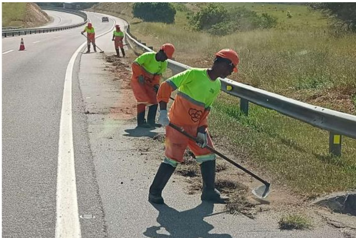
Figura 4.11 Via Lagos - Refilamento - km 44+700 Norte
