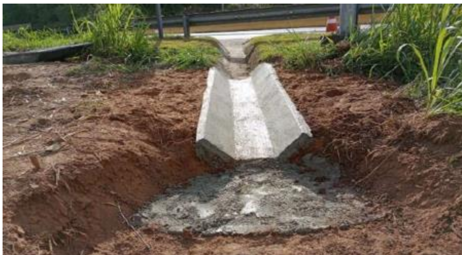
Figura 4.17 Via Lagos - Implantação drenagem superficial - Km 19+500 Norte
