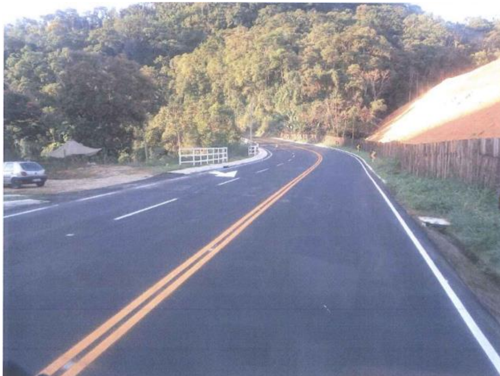
Figura 4.17 Rota 116 – Restauração de pavimento– km 98 -99
