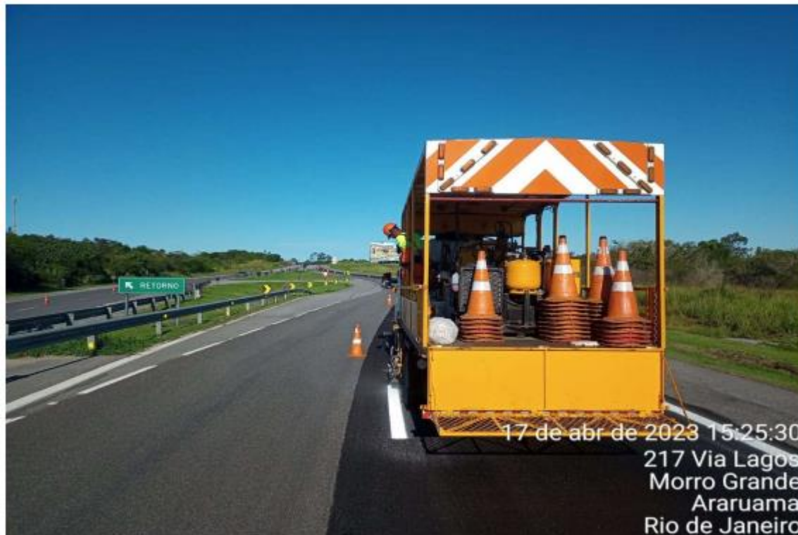
Figura 4.6 Via Lagos - Sinal Horizontal - Km 34+340 Norte
