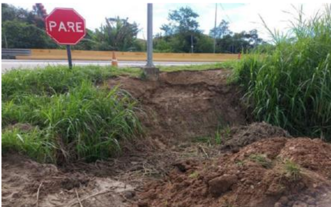
Figura 4.18 Via Lagos - Recuperação de talude - Km 5+800 Norte
