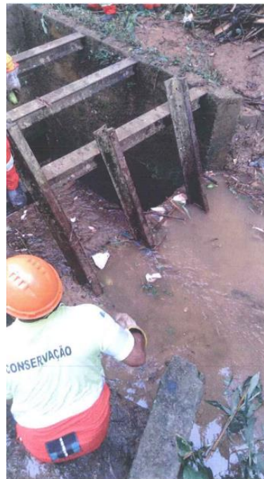
Figura 4.14 Rota 116 – Limpeza de bueiro – Km 78,5
