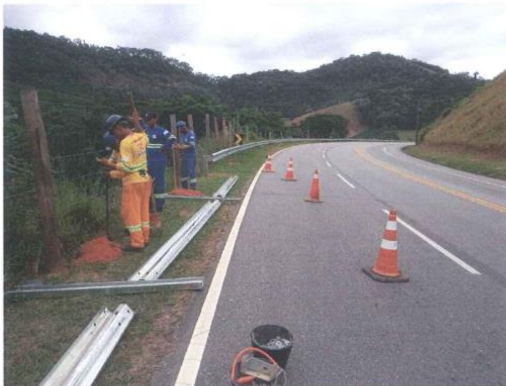
Figura 4.15 Rota 116 – Implantação de defesa metálica– km 112.5
