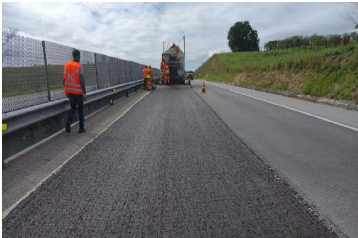
Figura 4.3 Via Lagos - Pista - Microrevestimento- KM 42 Norte
