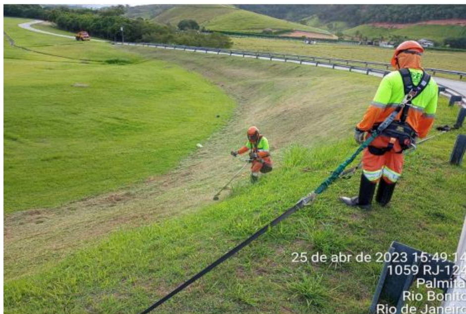
Figura 4.14 Via Lagos - Roçada Manual Talude - km 21+180 Norte
