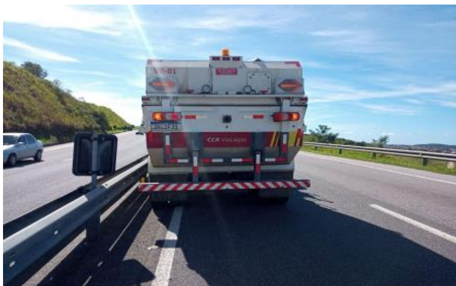
Figura 4.16 Via Lagos - Varrição mecânica - km 46+600 Norte
