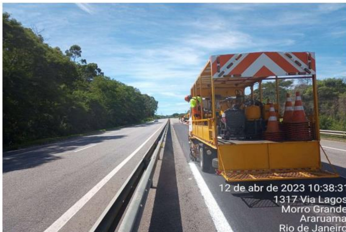
Figura 4.5 Via Lagos - Sinal Horizontal - Km 26+460 Norte
