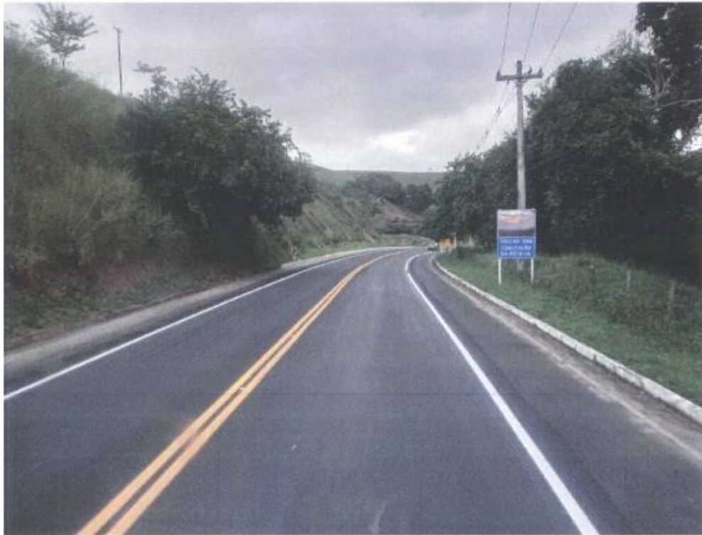
Figura 4.18 Rota 116 – Restauração de Pavimento – Pintura - km 133.5 ao 133.78
