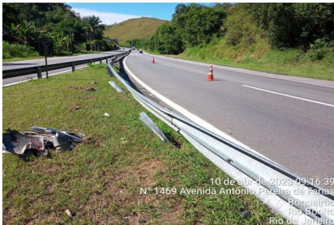
Figura 4.9 Via Lagos - Defesa - km 1+900 Norte
