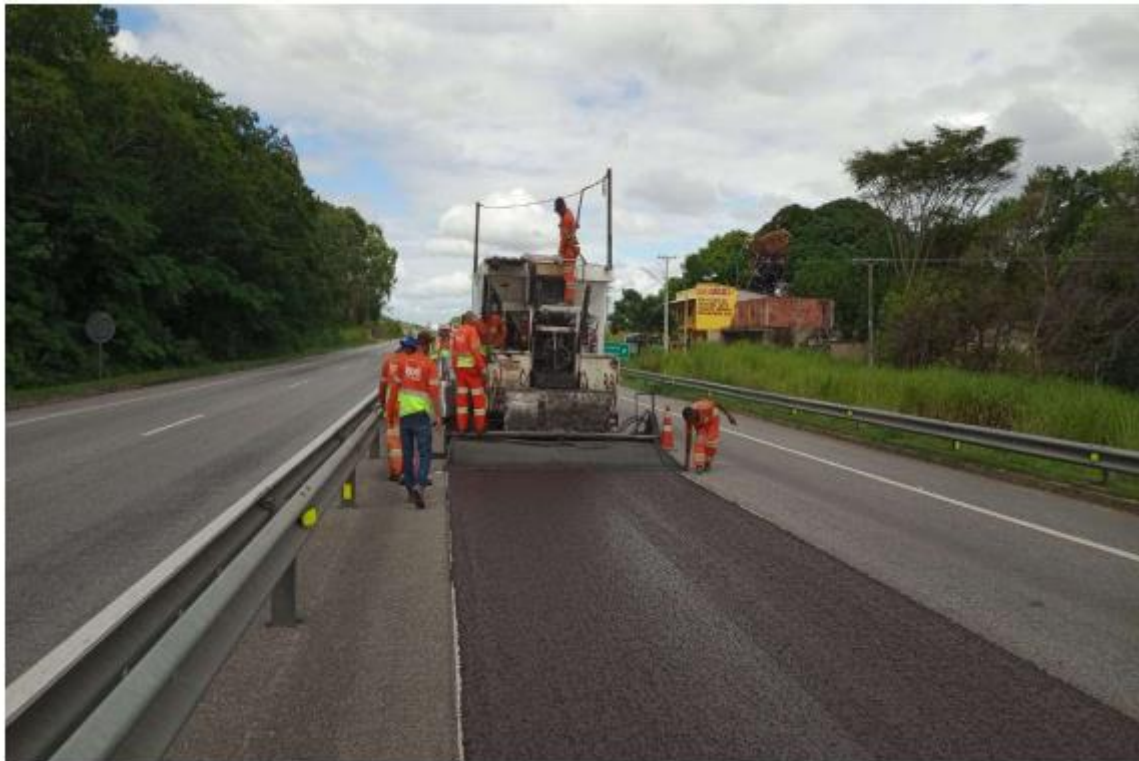
Figura 4.2 Via Lagos - Pista - Microrevestimento- KM 26 Norte
