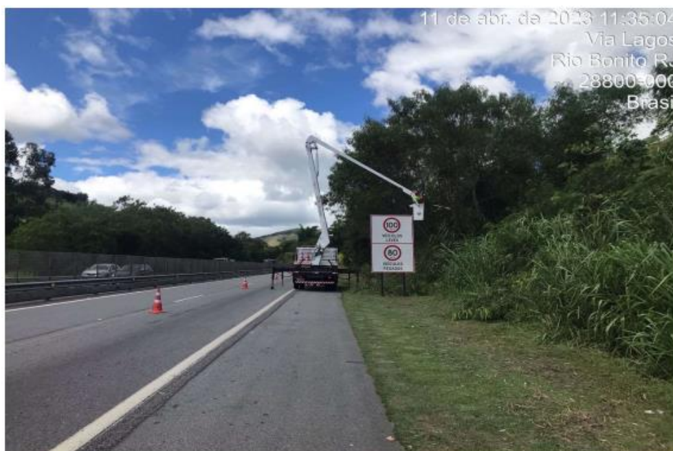
Figura 4.13 Via Lagos - Poda Galhos - km 6+300 Norte
